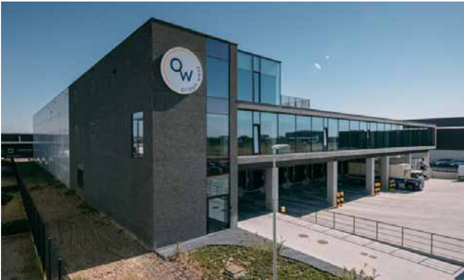
Vandaag draait het nieuwe magazijn van Orizon West op volle toeren. Mede dankzij het WMS loopt de logistieke werking nu veel vlotter. Ook de routing door het magazijn zit nu logisch in elkaar.
